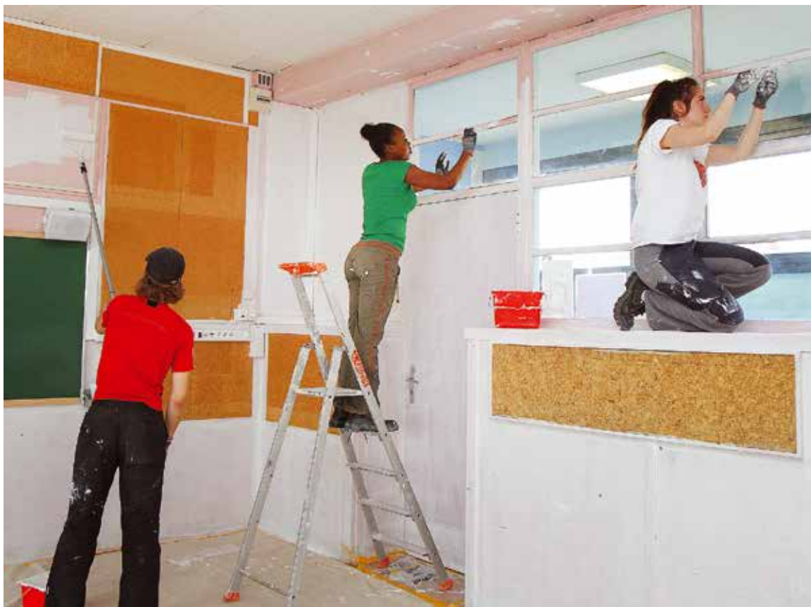
Encadrés par les agents du Centre technique municipal, des jeunes rénovent des bâtiments publics lors des chantiers d'été.
