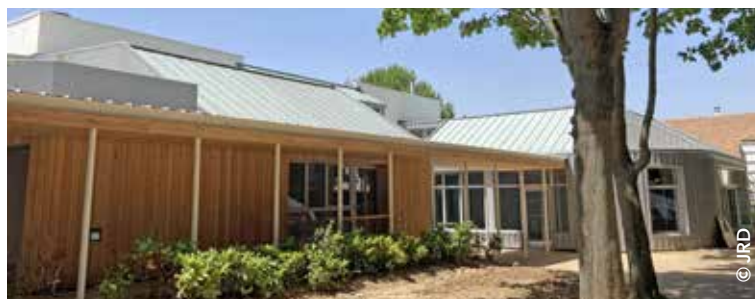
Le nouveau visage de l'école Jacques Gilbert-Collet, tout de bois et de métal, après sa rénovation énergétique.
