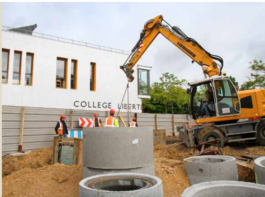
Des travaux d'assainissement ont notamment eu lieu dans le cadre de la réfection de la rue de Verdun en 2016.
