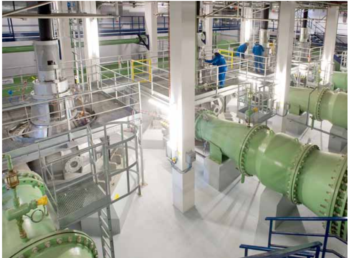
L'eau consommée à Chevilly-Larue vient de l'usine du Sedif de Choisy-le-Roi qui produit en moyenne 313 000 m 3 par jour pour près de deux millions d'habitants. Issue de la Seine, cette eau est désinfectée afin d'assurer sa qualité et sa conservation.
