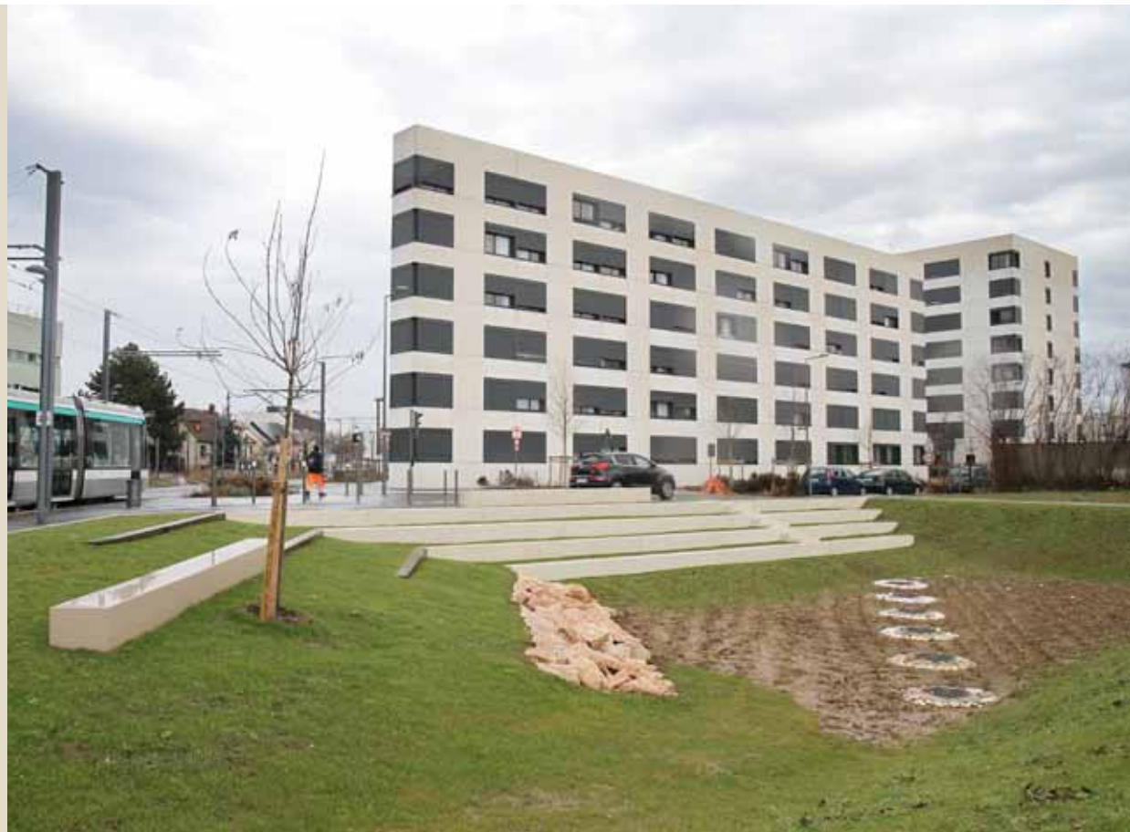
Le bassin de rétention du Triangle des Meuniers permet de récupérer les eaux de pluie et apporte un coin de verdure dans le quartier.
