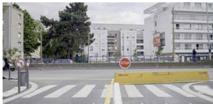
Au carrefour de la rue de la Sécurité parisienne et de la RD7, les travaux ont commencé.
