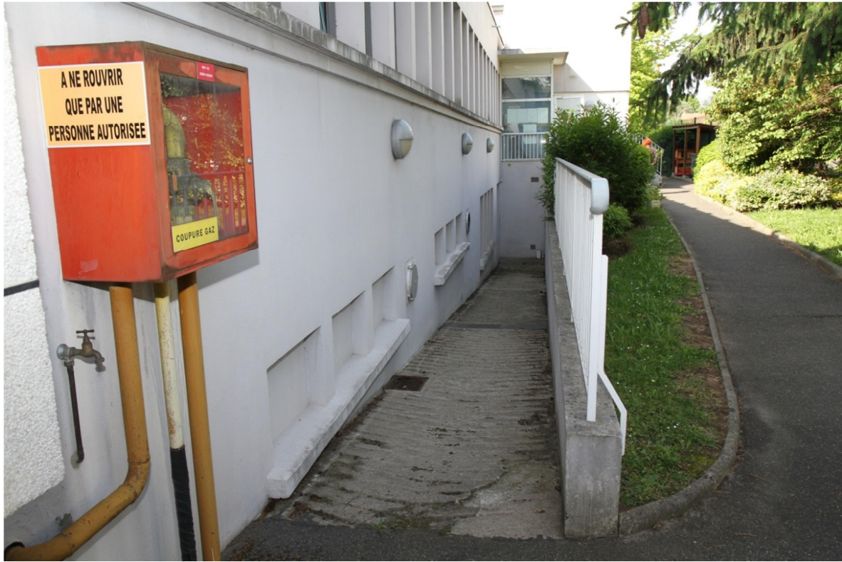
Façade Nord-Ouest, côté rue Jules Verne Rampe PMR, accès sous-sol
