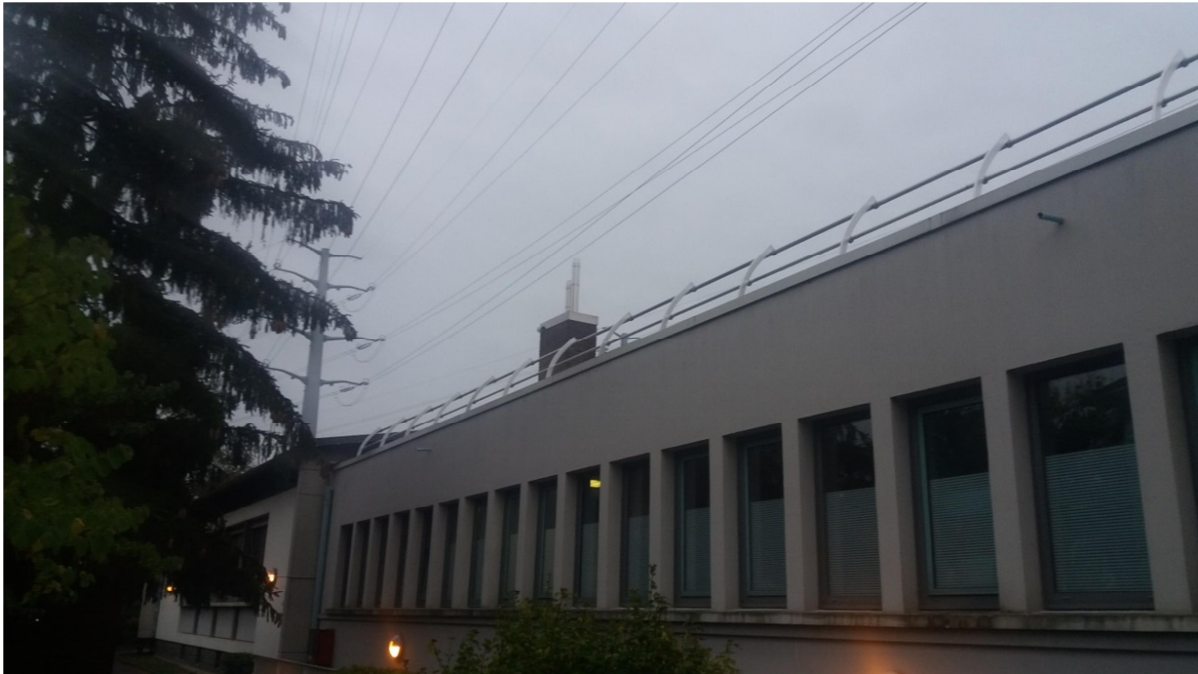
Façade Sud-Est, côté bassin Maurice Chevalier
